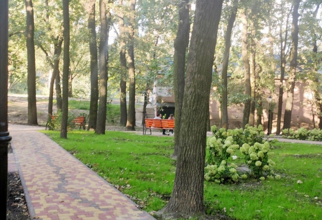
Капітальний ремонт пішохідних зон в парку Дубки вул. Каштанова
