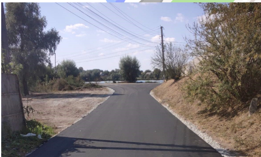
Капітальний ремонт дороги по вул. Лесі Українки в с. Красне Перше
