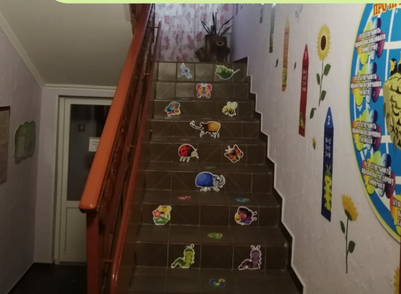
капітальний ремонт сходових клітин Дошкільного навчального закладу (ясла-садок) комбінованого типу «Світлячок»
